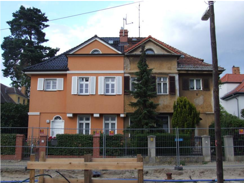
Figuur 32: Renovatie Bron: https://de.wikipedia.org/wiki/Sanierung_(Bauwesen)
